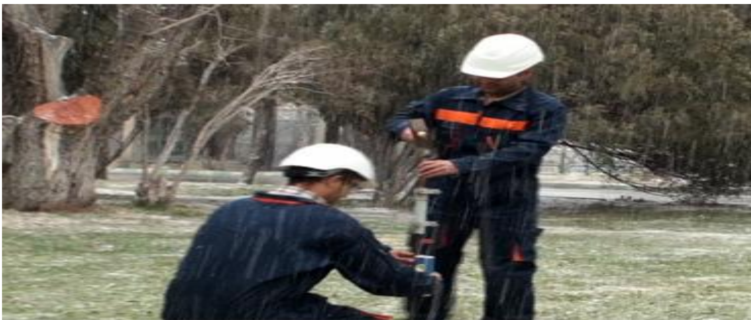
نصب پایه نگهدارنده
